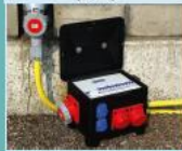
Stromverteiler mit Steckdosen (mobil)
