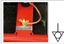
Abb. 1 Symbol 5021 „Schutzpotentialausgleich“ nach DIN IEC 60417
