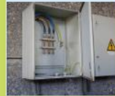
Stromverteiler mit Steckdosen (stationär)
