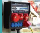
Stromverteiler mit Steckdosen (stationär)
