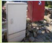
Baustromverteilerschrank
